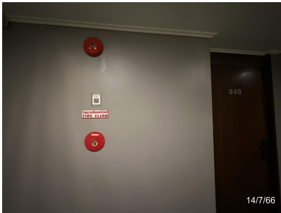
รูปที่ 1-7 สัญญาณแจ้งเตือนอัคคีภัย (Fire alarm) บริเวณชั้น 3 ตึก Tower wing
