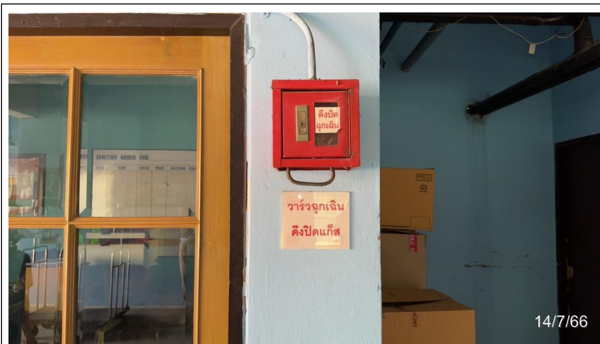
รูปที่ 1-15 วาร์วฉุกเฉินสำหรับดึงปิดแก๊ส บริเวณหน้าห้อง Cost control
